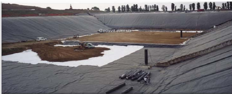
Рис. 2.2. Основание и гидроизоляция полигона ТБО
