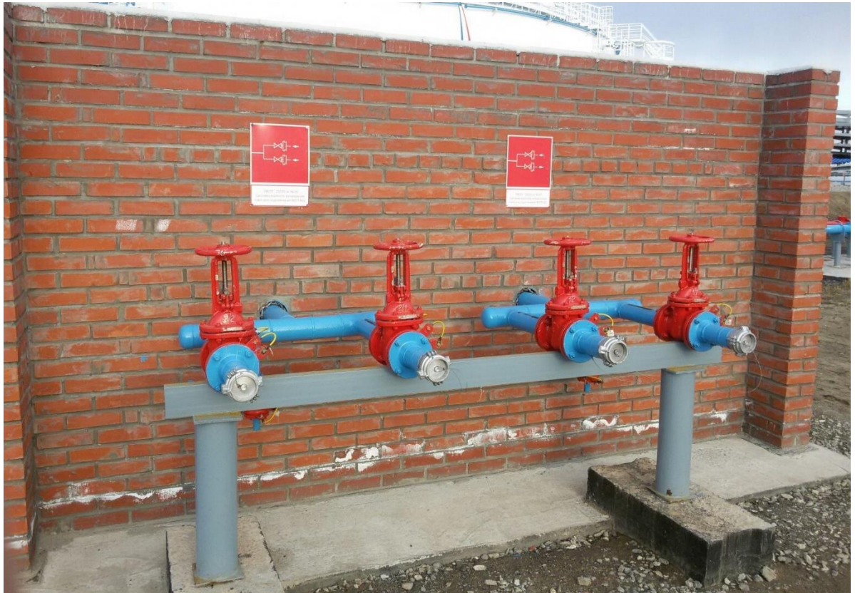
Рисунок 2.3 - Узел подключения водяного охлаждения
