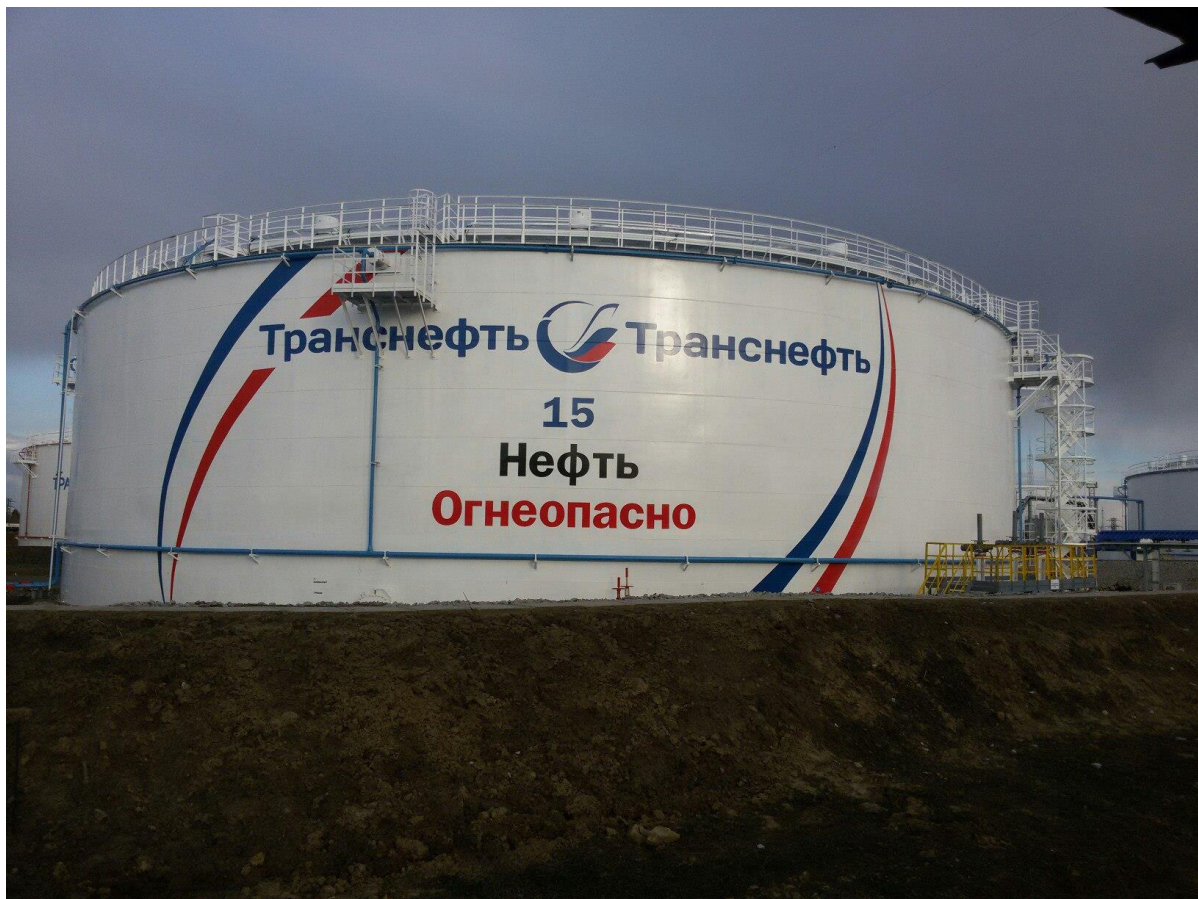
Рисунок 2.2 - Резервуар с нефтью РВС – 20000 м 3
