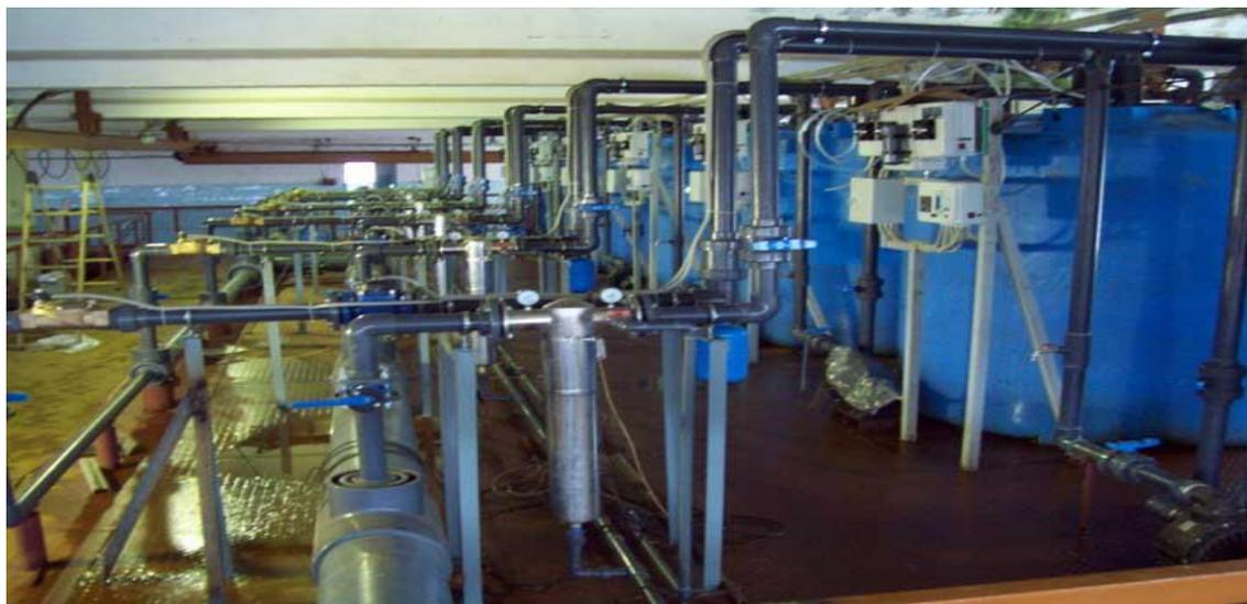
Рисунок 1.13 - Система водоподготовки по принципу озонирования.
